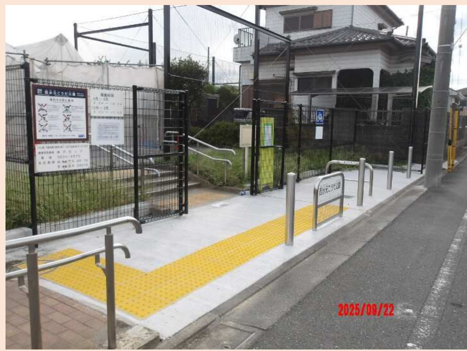
園内夜間閉鎖のため、門扉・フェンス設置
