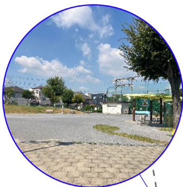
「高砂七丁目公園」 かまどベンチやマンホールトイレ を備えた柴又地区の防災活動拠点
