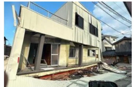
崩壊・傾斜した鉄骨造
