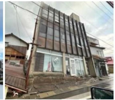
傾斜が残るRC造
