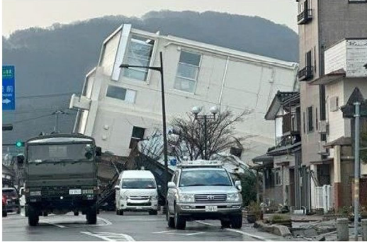
倒壊したRC造↓
