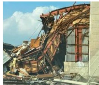
崩壊・傾斜した鉄骨造
