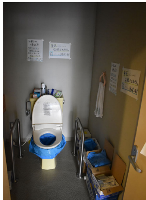
既設トイレを活用した「携帯トイレ」
