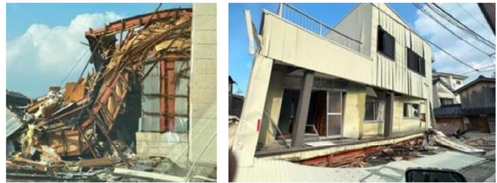
崩壊・傾斜した鉄骨造
