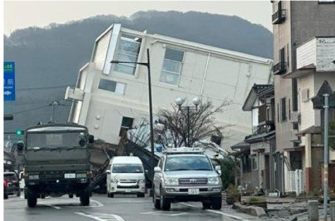
倒壊したRC造↓
