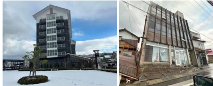
傾斜が残るRC造
