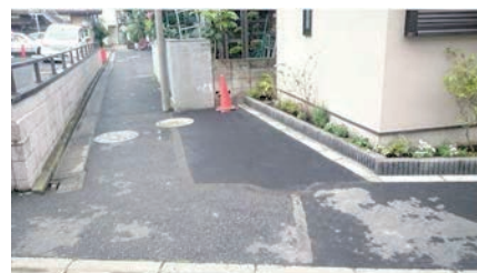
細街路拡幅整備（後）
