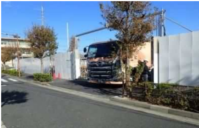
仮囲い及びゲート
