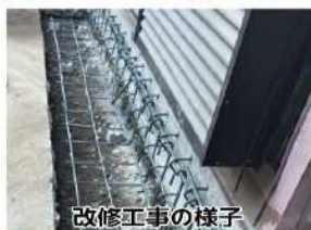
改修工事の様子
