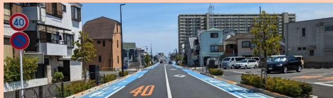
人・自転車・車それぞれが安全で快適な道路 〔区内整備例：補助284号線 東新小岩南区間（幅員16m）〕
