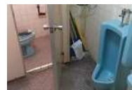
▲改修前(トイレ)
